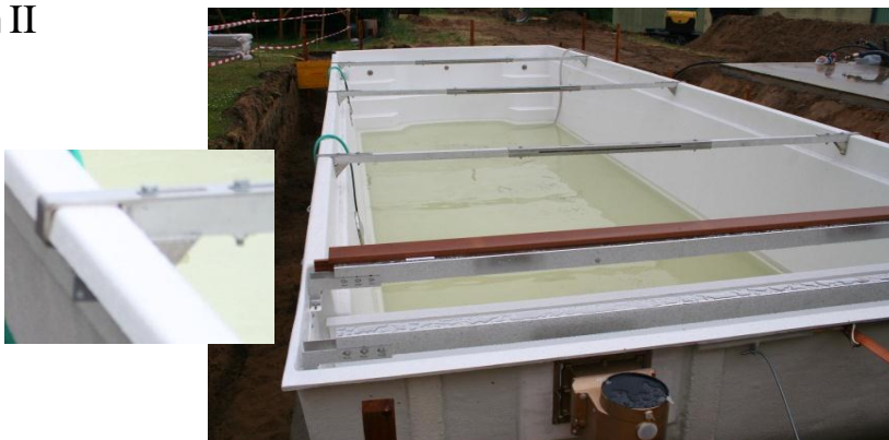
Abb. 7. - Einbauskeizze der Seitenstützen zu den Schwimmbecken. Mit Hilfe der Seitenstützen kann nach Aushärten der Betonneste die Feineinstellung der Seitenwände leicht durchgeführt werden
