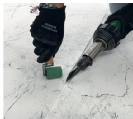
2. Schweißnaht
